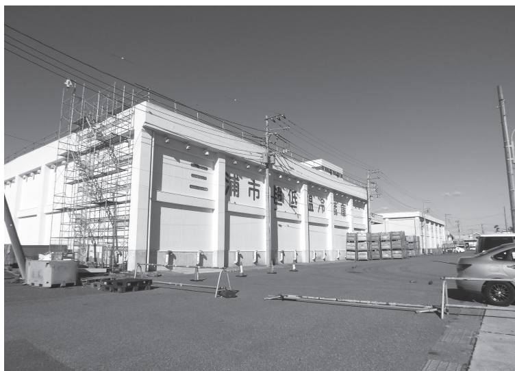
▲三崎港にある超低温冷蔵庫
